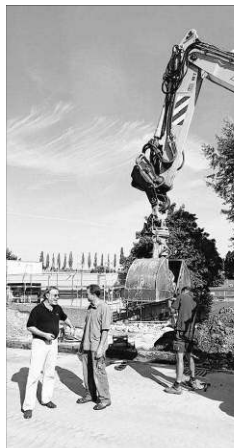
Schulleiter Walter Keller (l.) im Gespräch mit Bauleiter Markus Barth.
